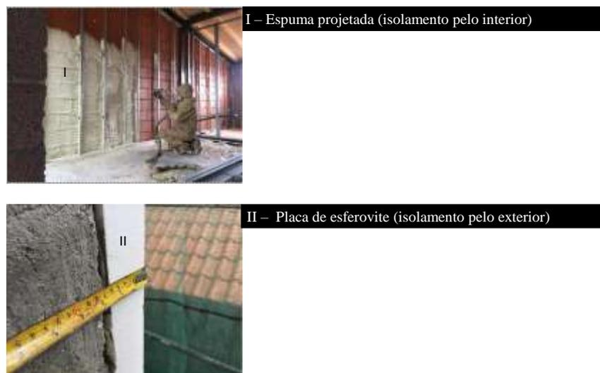
Figura 3.25 - Alguns materiais de isolamento térmico para paredes
