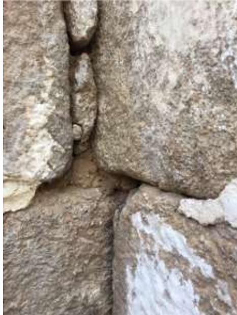
Figura 3.5 - Argamassa de junta em terra
