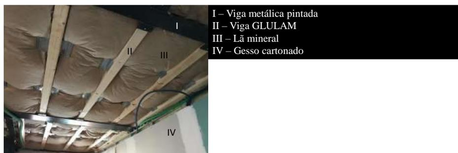
Figura 3.26 - Isolamento de pavimento com lâ mineral
