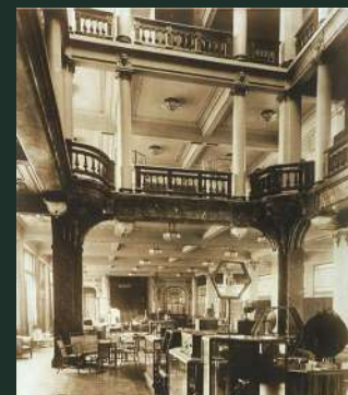
Armazém Nascimento – Marques da Silva, 1914 Construção em sistema Hennebique
