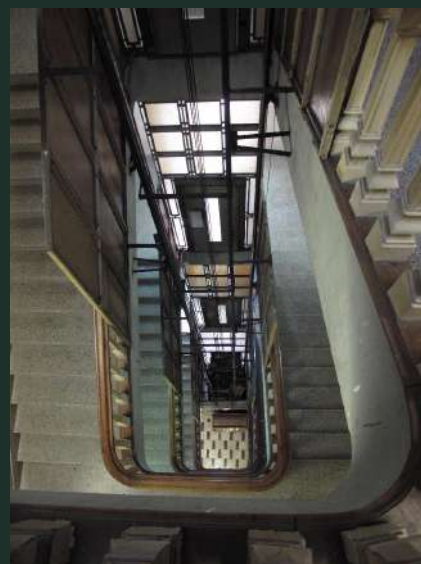
Edifício FCP – AV. Aliados Manuel Marques - 1933
