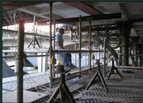
Medição de deslocamentos na face inferior
