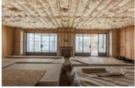
Aplicação de lã de ovelha como material de isolamento térmico
