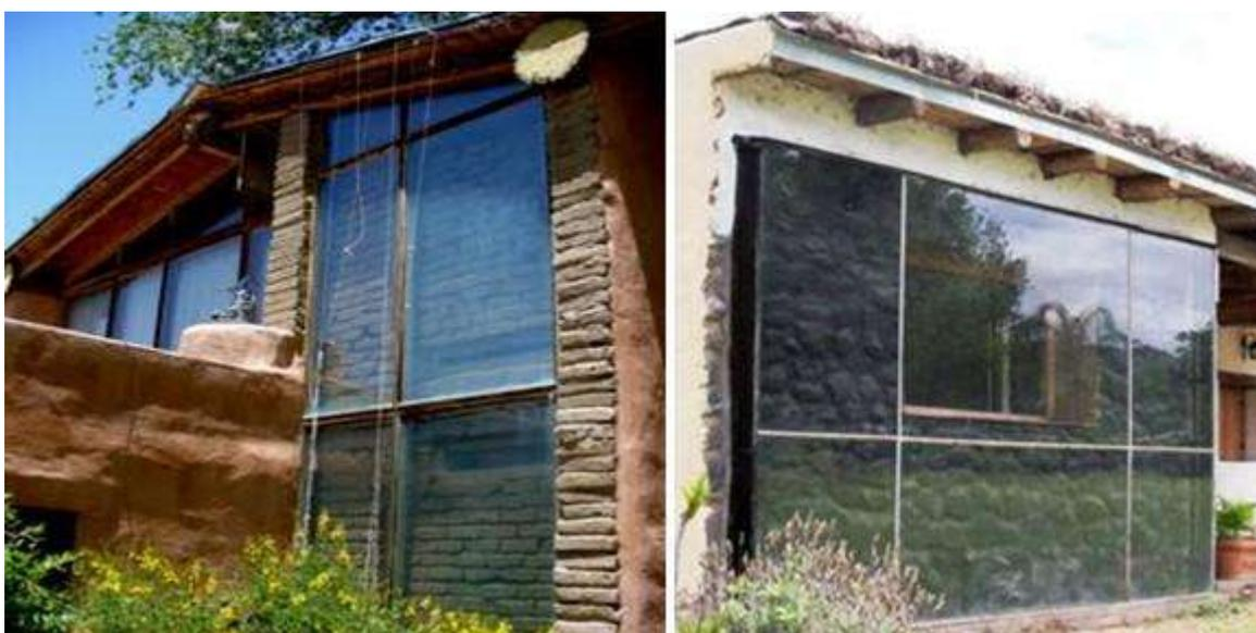
Figura 2.23 - Exemplos de aplicação de paredes de Trombe: a) em adobe; b) em alvenaria de pedra irregular
