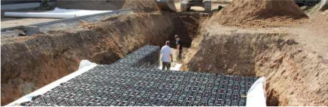
Figura 2.9 - Sistema de recolha e armazenamento de água pluvial de escorrência
