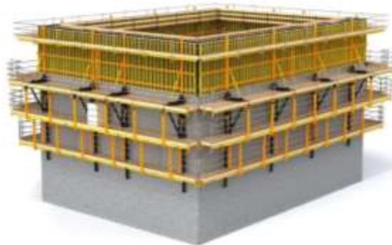
Figura 6.37 - Cofragem autotrepante
