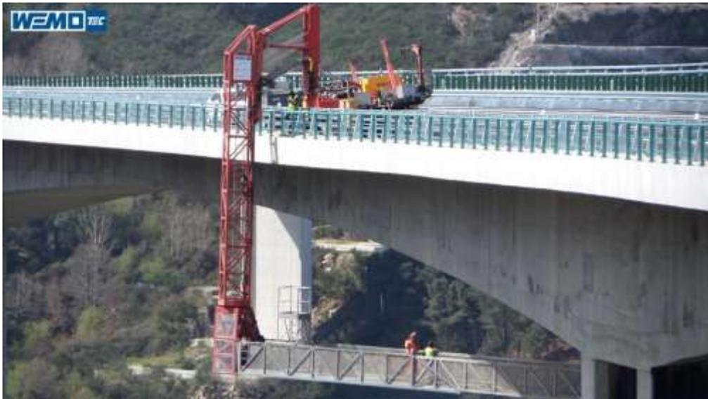
Figura 6.62 - Inspeção dos viadutos com recurso a plataformas suspensas
