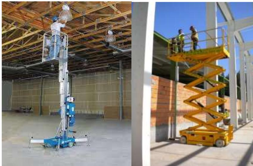
Figura 6.30 - Plataformas de trabalho elevatórias utilizadas na substituição de lâmpadas
