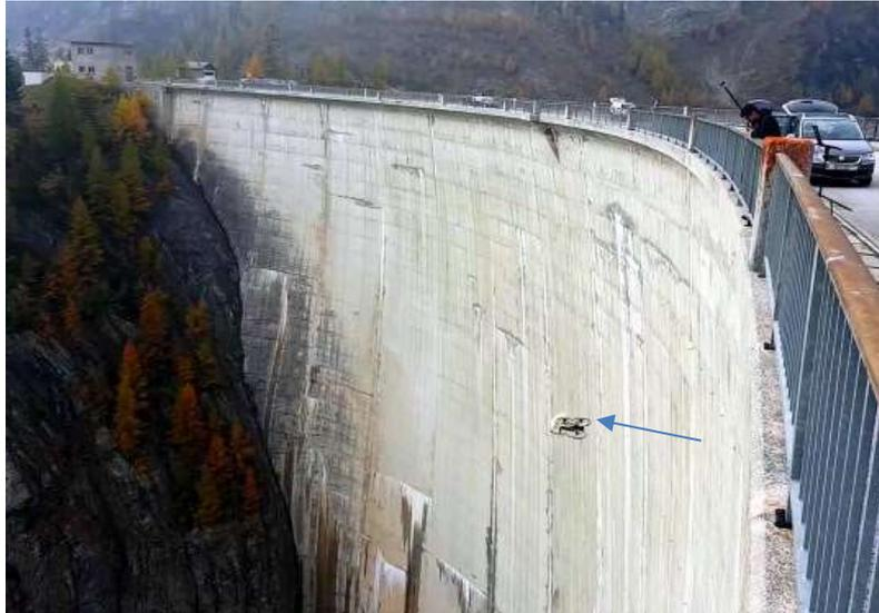
Figura 6.53 – Exemplo de drone na inspeção de barragem
