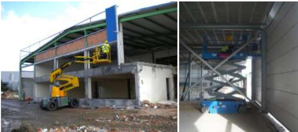
Figura 6.27 - Exemplos de plataformas para trabalhos em altura em estruturas metálicas
