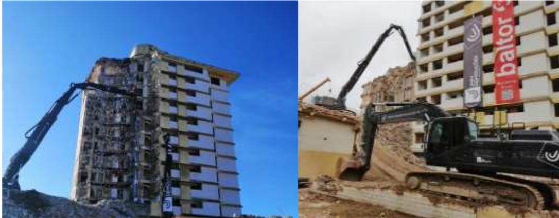
Figura 6.24 - Desconstrução da estrutura de betão armado do Edifício Coutinho com uma máquina de longo alcance
