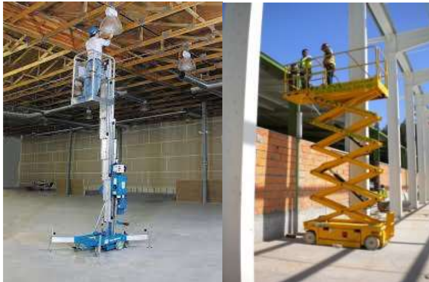
Figura 6.30 - Plataformas de trabalho elevatórias utilizadas na substituição de lâmpadas Fonte: Carlos Oliveira
