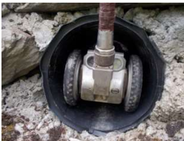
Figura 6.56 - Inspeção das passagens hidráulicas com recurso a robôs Fonte - Egis, Road Operation Portugal
