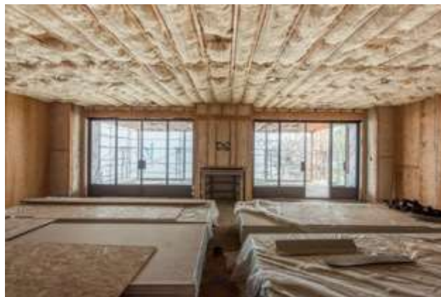
Figura 3.15 - Aplicação de lã de ovelha como material de isolamento térmico
