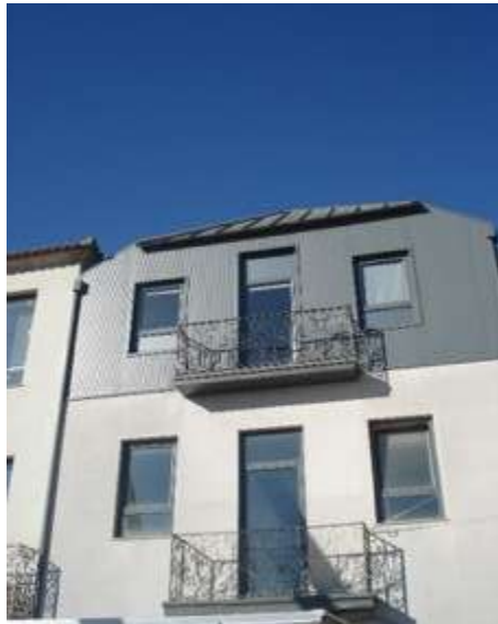
Figura 3.20 - Reabilitação com ampliação de um piso com recurso a estrutura em aço leve
