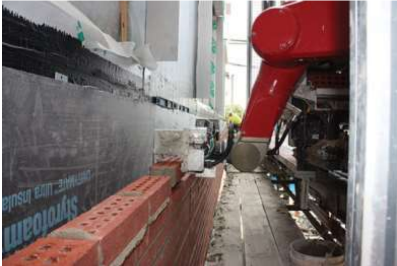
Figura 4.17 - Robô para colocação de tijolos
