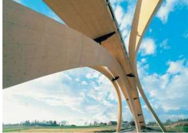
Figura 4.8 - Ponte pedonal pré-fabricada em GLULAM. Exemplo de estaleiro de obra “limpo”. Arcos seccionados aos terços para possibilitar transporte da oficina para o local da obra
