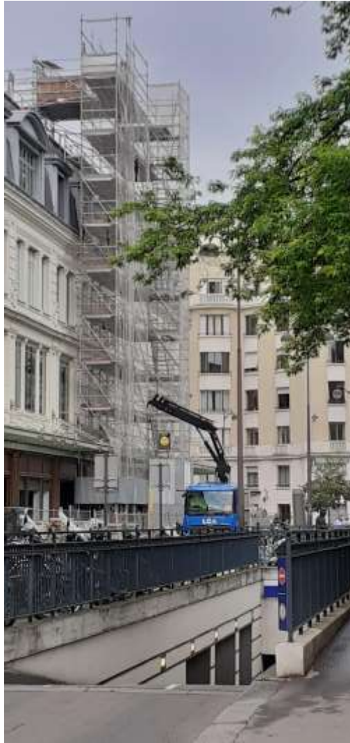
Figura 6.35 - Utilização de andaimes homologados
