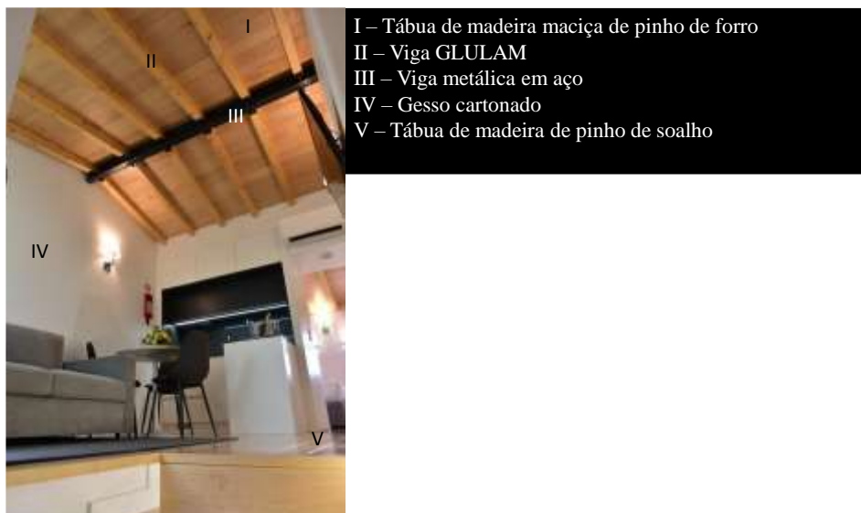
Figura 3.21 - Aplicação de GLULAM ao nível da cobertura
