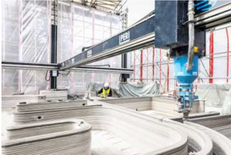
Figura 4.14 - A impressão 3D de uma residência na Alemanha
