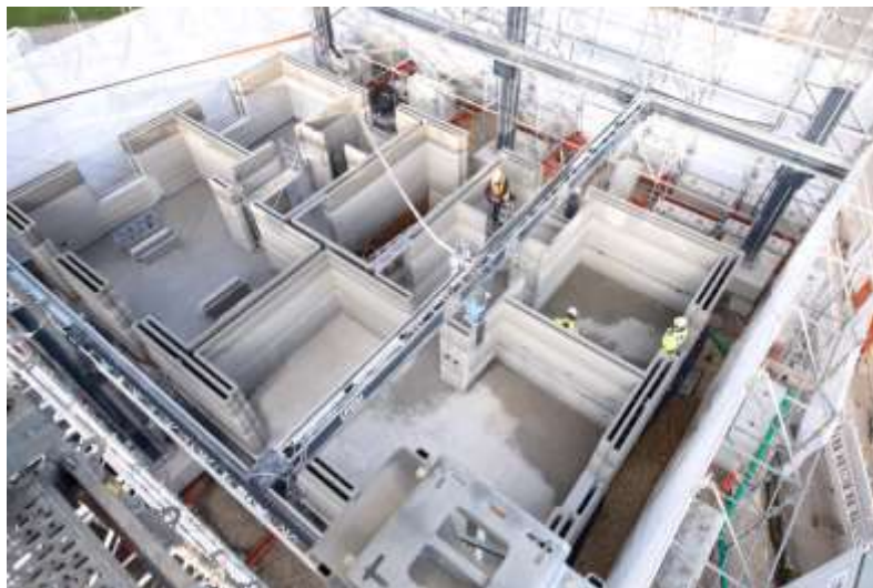
Figura 4.15 - Vista superior da impressão 3D de uma residência na Alemanha
