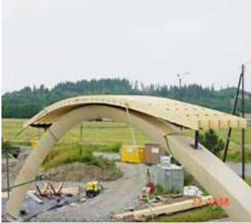
Figura 4.8 - Ponte pedonal pré-fabricada em GLULAM. Exemplo de estaleiro de obra “limpo”. Arcos seccionados aos terços para possibilitar transporte da oficina para o local da obra
