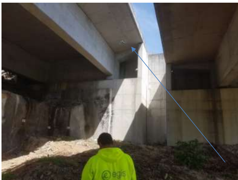
Figura 6.63 - Inspeção dos viadutos com recurso a drones Fonte - Egis, Road Operation Portugal
