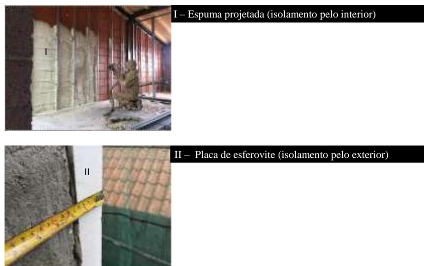
Figura 3.25 - Alguns materiais de isolamento térmico para paredes
