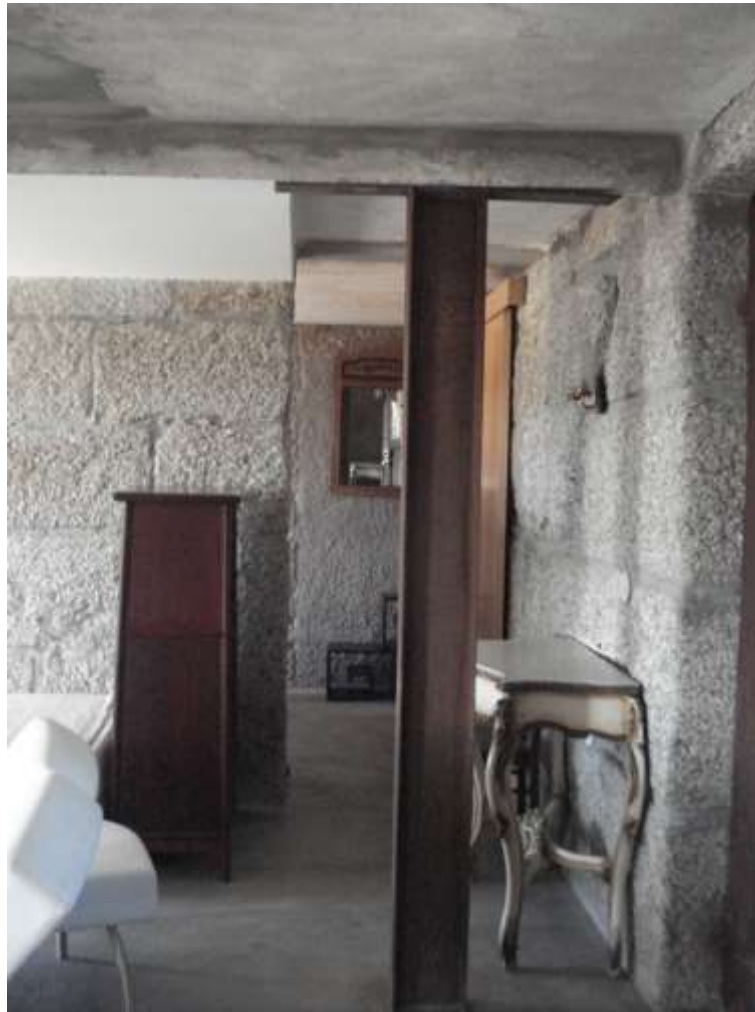
Figura.3.19 - Reforço estrutural com inclusão de pilar metálico numa obra de reabilitação
