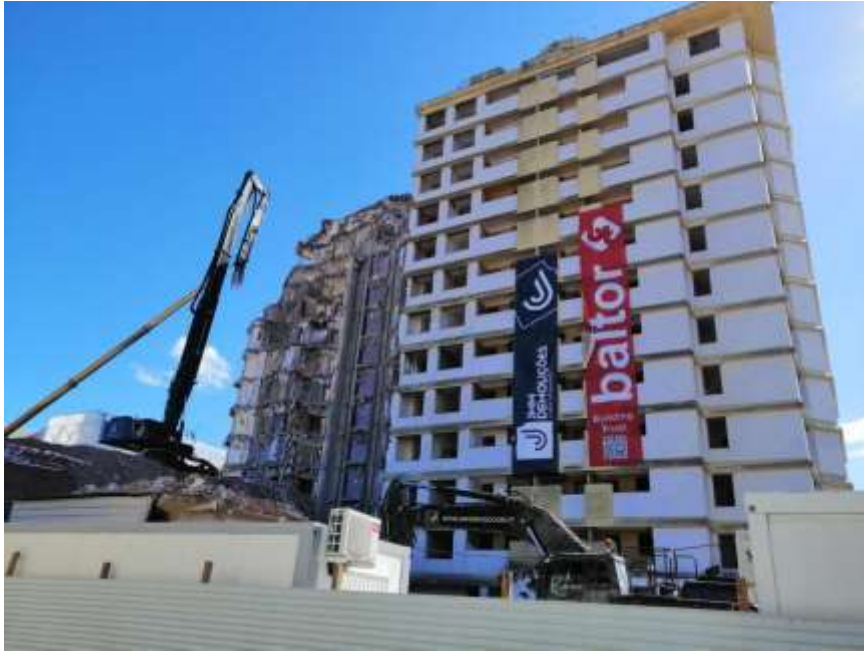
Figura 6.23 - Aspeto geral da desconstrução do edifício Coutinho em Viana do Castelo
