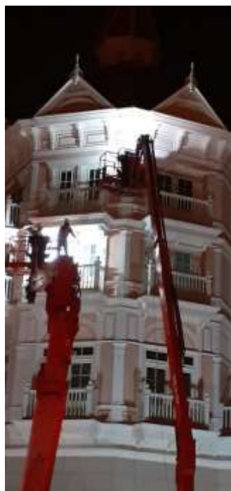
Figura 6.29 - Pormenor do uso de plataformas elevatórias em obras de reabilitação do hotel da Disney Land Paris Fonte: Cristina Reis
