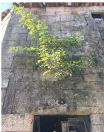
Figura 3.1 - Alvenaria de granito (cantaria)
