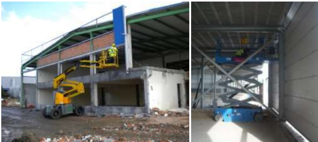
Figura 6.27 - Exemplos de plataformas para trabalhos em altura em estruturas metálicas Fonte -Carlos Oliveira
