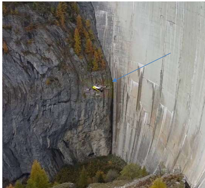
Figura 6.52 - Utilização de drones para inspeção de barragens Fonte - Inspeção de barragens com uso de drone | www.dronefilmagemarea.com
