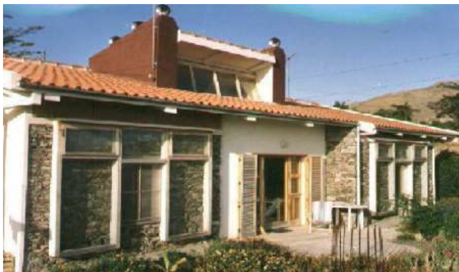
Figura 2.22 - Paredes de Trombe na Casa Shafer (Porto Santo)
