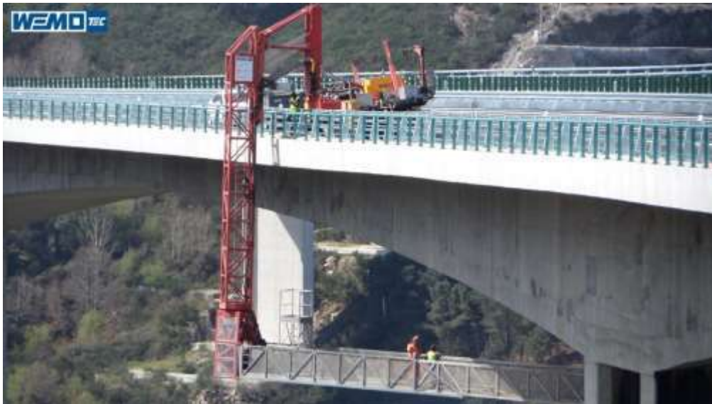
Figura 6.62 - Inspeção dos viadutos com recurso a plataformas suspensas Fonte - MBI 180 – WEMO-TEC
