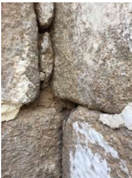
Figura 3.5 - Argamassa de junta em terra
