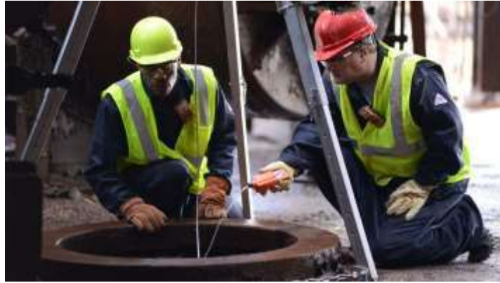
Figura 6.50 - Medidor de gases nos trabalhadores e nos locais confinados Fonte - Detecção de Gases - Tudo que você precisa saber - LEL Ambiental
