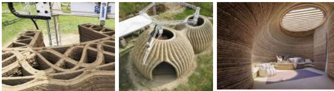
Figura 4.10 - Primeira construção em impressão 3D com materiais naturais
