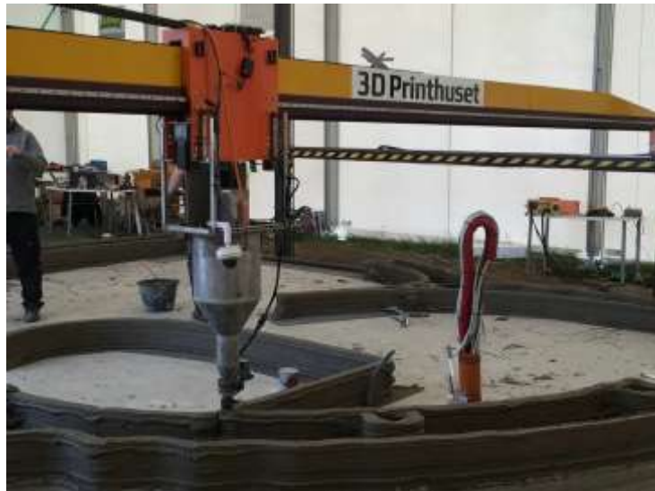
Figura 4.11 - Exemplo de Contour Crafting Fonte - https://www.hisour.com/pt/contour-crafting-40687
