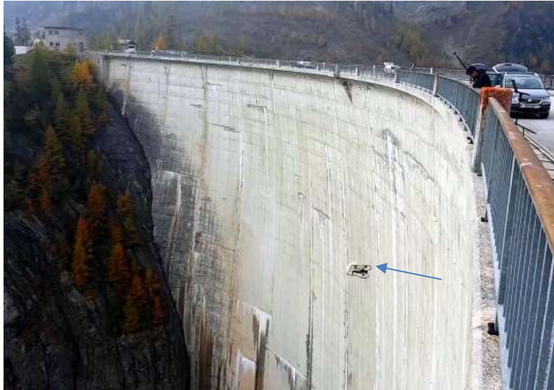
Figura 6.53 – Exemplo de drone na inspeção de barragem
