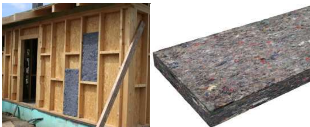
Figura 3.13 - Materiais de isolamento térmico e acústico à base de resíduos têxteis
