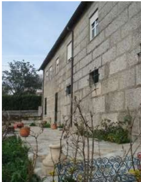
Figura 3.7 - Aplicação de cobre em sistemas de drenagem de águas pluviais em coberturas
