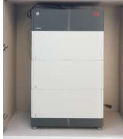
Figura 2.21 - Construção com sistema solar fotovoltaico com bateria de 3 módulos
