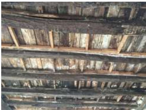
Figura 3.2 - Pavimento em madeira
