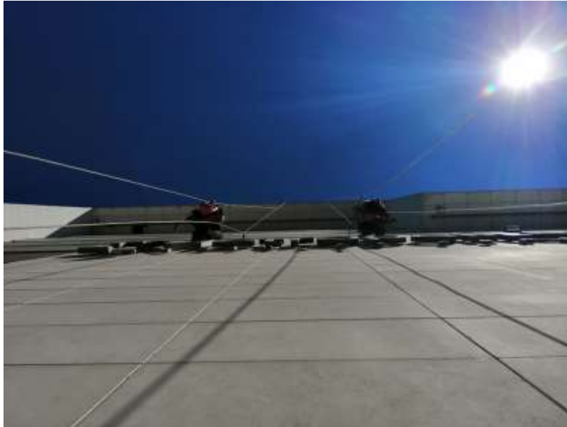
Figura 6.54 - Limpeza das fachadas de edifícios com recurso a equipamento de alpinismo
